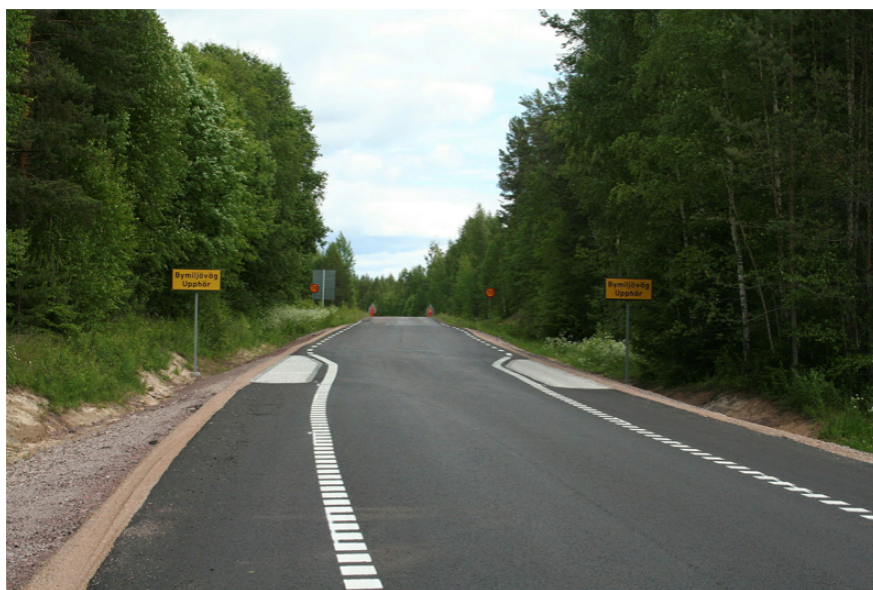
Figur 77 Bygdeväg, synonymt kallad Bymiljöväg.
